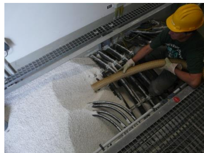
Bild F Entleeren des Kabelkellers
